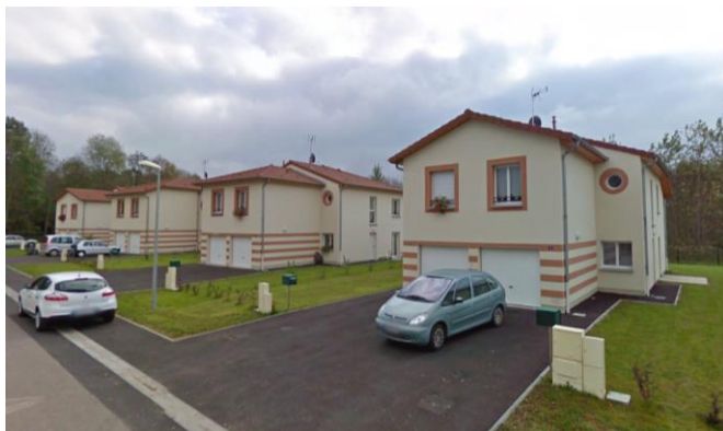
Pagny-sur-Meuse, opération de maison mitoyenne
